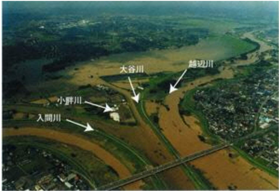
平成11年8月集中豪雨(熱帯低気圧)時 入間川・小群川・大谷川・越辺川合流部 (荒川上流河川事務所提供)
